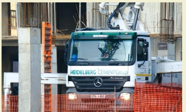
Prošlo je već devet mjeseci od početka betonskih radova na Sarajevo City Center-u, objektu na koji se isporučuje beton vrhunske kvalitete iz naše TBG poslovnice u Sarajevu. Do sada je na objekat isporučeno oko cca 50.000 m<sup>3</sup> betona, na gradilištu su angažovane tri pumpe za beton, a deset miksera danonoćno dostavljaju beton.
