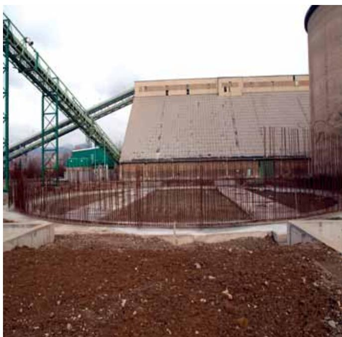
građevinskog održavanja. „Hidrauličnim putem ćemo podizati oplatu i koristiti brzovezujući cement, tako da očekujemo da ćemo dnevno graditi po dva metra zida.“ Preliminarne kalkulacije pokazuju da će za betoniranje zida biti utrošeno oko 2.000 kubika betona.
