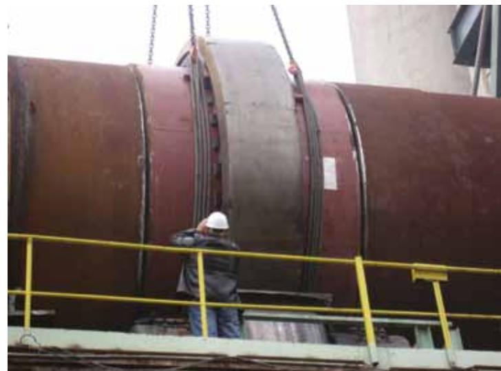
ploča i bočnih graničnika bez promjene nosivog prstena pošto iste nisu direktno zavarene za plašt peći. Na taj način je moguće postići odgovarajuću, odnosno projektну zračnost između nosivog prstena i podložnih ploča koja iznosi 6-8 mm u hladnom stanju. Sa ovom zamjenom ćemo postići daleko stabilniji i mirniji rad rotacione peći, a time i smanjiti troškove koji su se odnosili na česte popravke pomenute nosive stanice.
