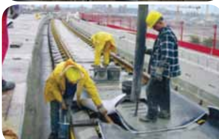
Slika 11. Proces proizvodnje i ugradnje montažnog sistema OBB - PORR
