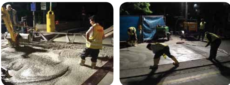
Slika 9+10: postavljanje i zbijanje (lijevo); betonska površina - teksturiranje pomoću glačanja (desno)
