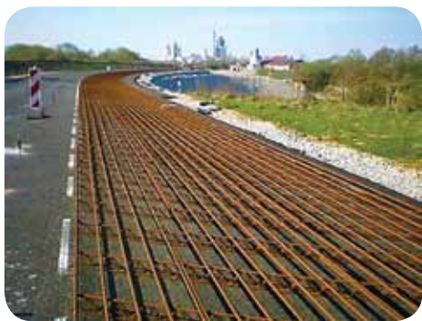
Slika 1+2: Kontinuirano armiranje, finiše za beton na traci 1
