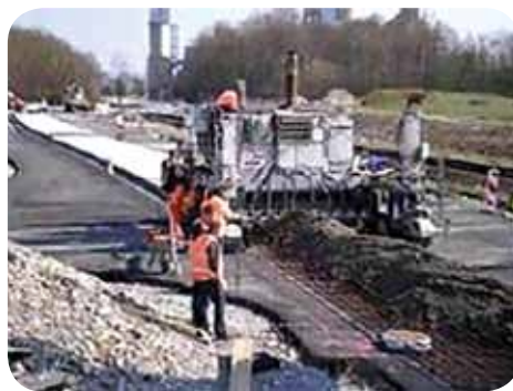
Slika 1+2: Kontinuirano armiranje, finiše za beton na traci 1
