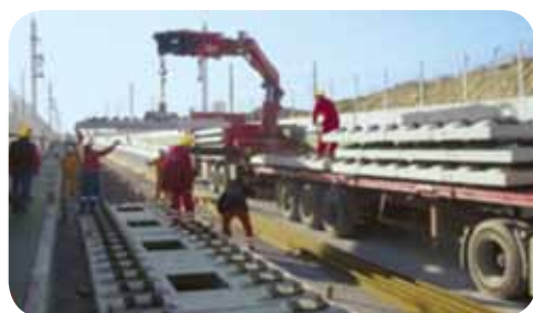
Slika 11. Proces proizvodnje i ugradnje montažnog sistema OBB - PORR
