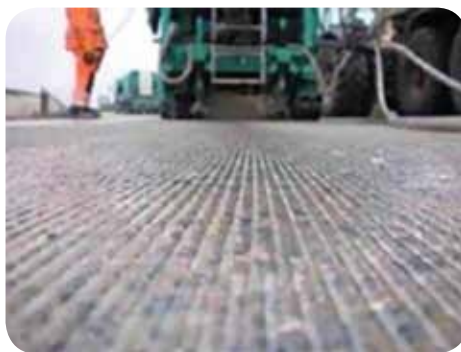
Slika 3: Površina nakon brušenja, razmak oštrica 2 mm
