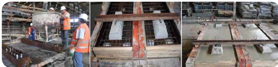
Slika 15. Proces proizvodnje prototipa kolosijeka na čvrstoj podlozi „ECOTRACK“
