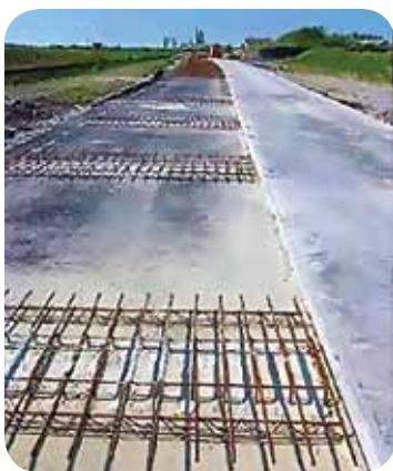
Slika 4+5: Prva traka s povezanim šipkama (lijevo); Krajnji podupirači u drugoj traci (desno)
