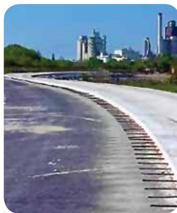
Slika 4+5: Prva traka s povezanim šipkama (lijevo); Krajnji podupirači u drugoj traci (desno)
